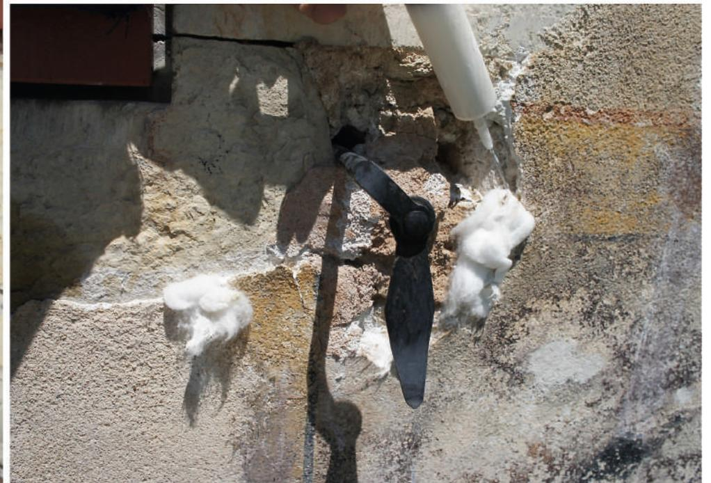
Consolidations par injections à la seringue de PLM-A. L'enduit a été consolidé jusque sous les fenêtres, une reprise de l'enduit sur la façade devrait être envisagé, toutefois il faudrait que le maçon conserve le maximum de l'enduit existant.
