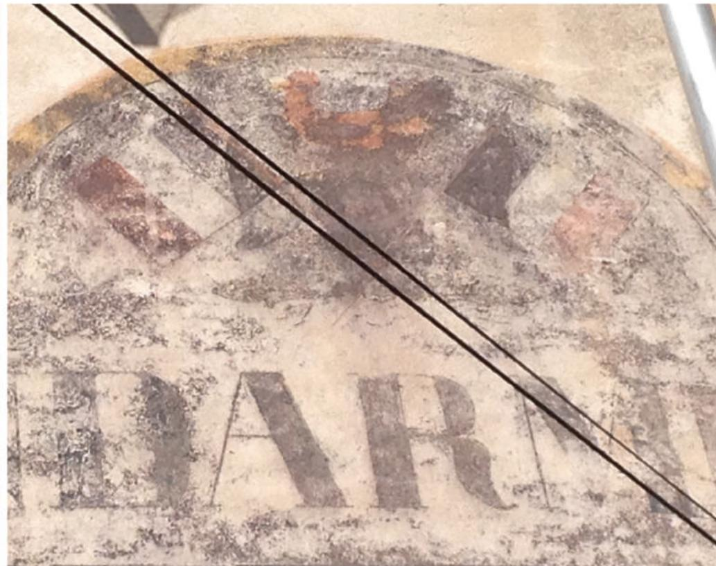
Avant intervention. Le panneau est couvert de calcifications, d'encrassements, une gouttière et un câble électrique sont fixés dans le panneau, des consolidations de l'enduit sont nécessaires.
