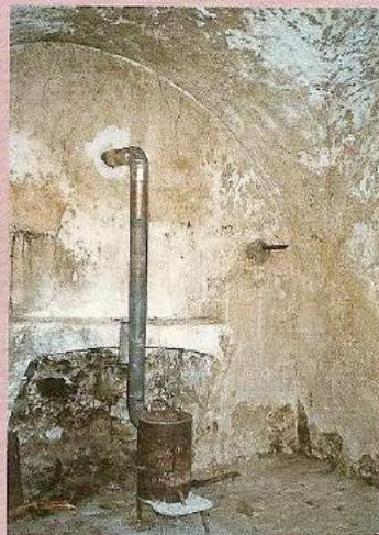
Une pièce en voûte d'arêtes au sol dallé de pavés de terre cuite. Murs et plafond sont enduits finement et badigeonnés au lait de chaux.
