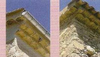
La finition en bas de pente se compose le plus souvent de géroises à un, deux voire trois rangs pour les édifices les plus nobles. On observe aussi quelques dépassées de toiture en bois, mais toujours dans la pente du toit et jamais fermées à l'horizontale par un lambris.
