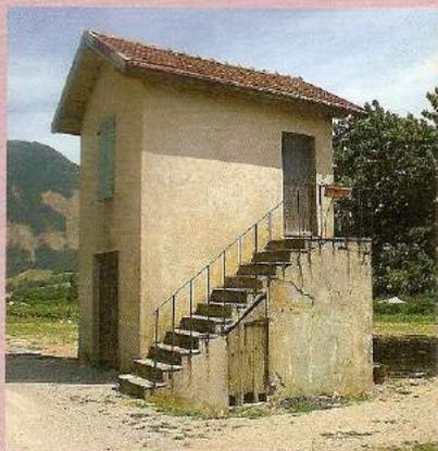
Dans les deux cas, les marches sont monolithes (composées d'un seul bloc de pierre ou de béton).
